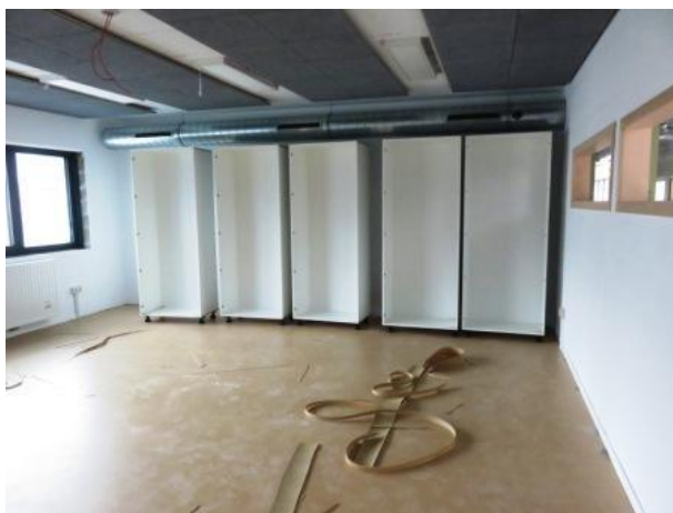
installation des armoires
