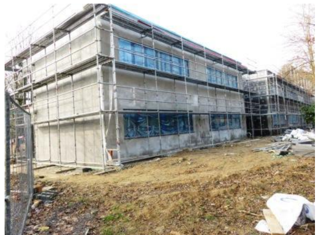
préparation du crépi (façade nord, côté avenue)
