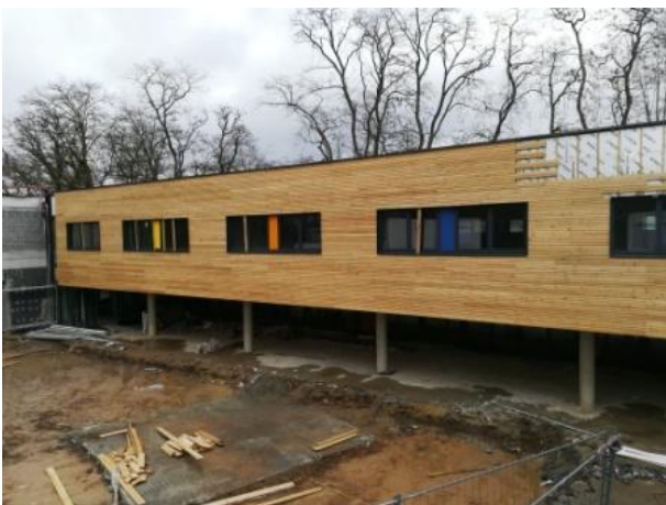
bardage de la façade sud (côté parc)
